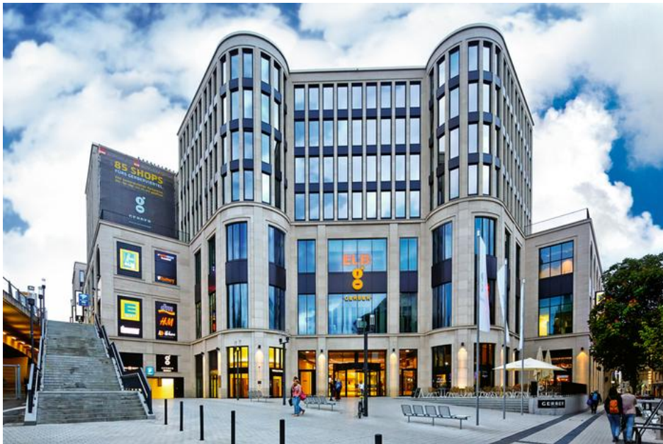
Das GERBER – Einkaufszentrum in Stuttgart ist mit TROX Produkten von Luftdurchlässen, Brandschutzsystemen bis hin zu Klimazentralgeräten ausgestattet
