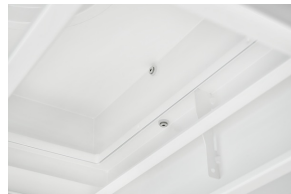
Detail Druckmessstelle
