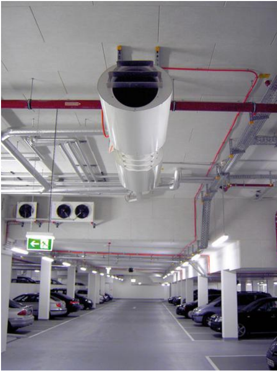
Jet-Ventilatoren werden zur Belüftung und Entrauchung von Garagen eingesetzt.
