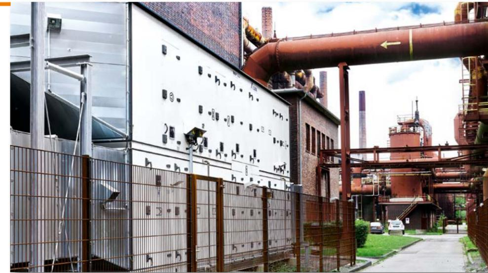
Ein spezielles X-CUBE RLT-Gerät für die Außenanstellung versorgt Halle und Erdgeschoss mit einem Volumenstrom von 56.000 m<sup>3</sup>/h mit ausreichend aufbereiteter Außenluft.
