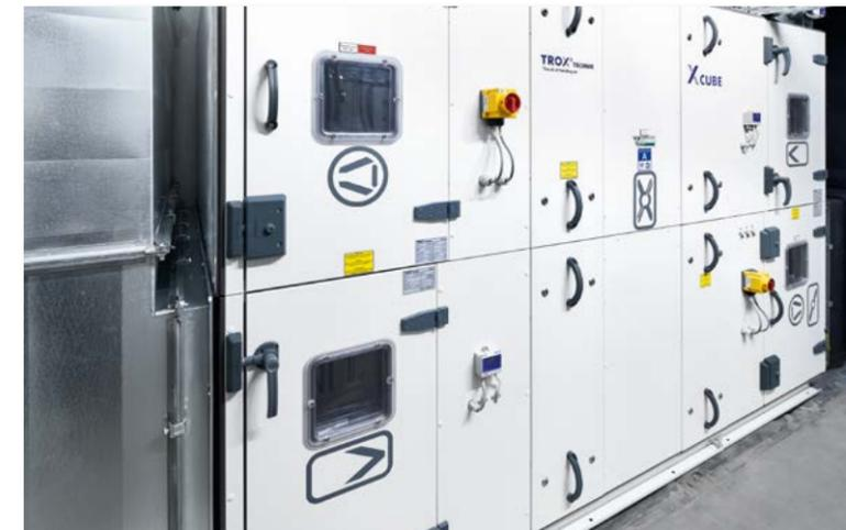
Ein kleines X-CUBE RLT-Zentralgerät im Untergeschoss führt bei Bedarf die Abluft aus dem Catering-Bereich ab.
