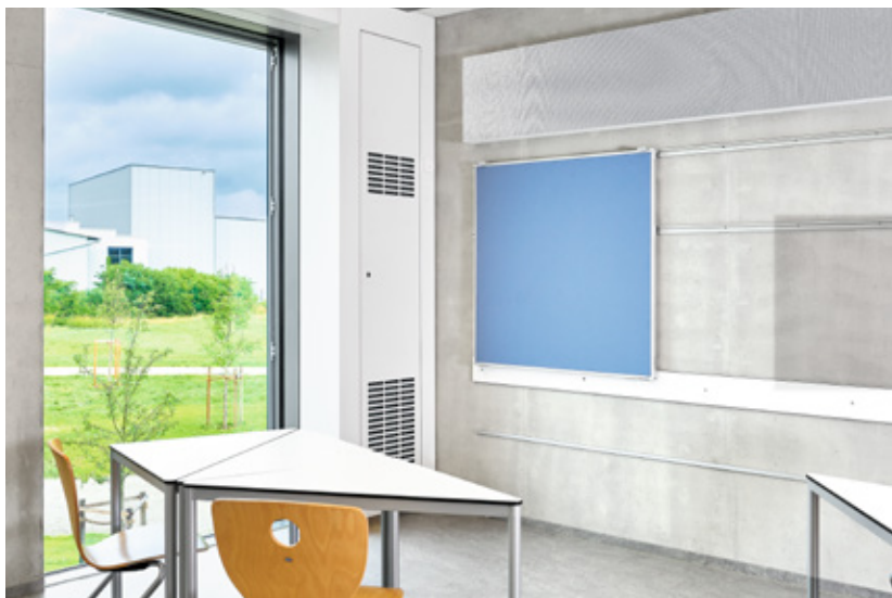
X-CUBE SCHOOLAIR-V-HV im Gymnasium, Wendelstein
