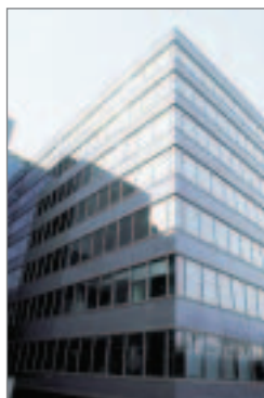
Foto 6: Rechenzentrum Neckermann (Frankfurt am Main)
