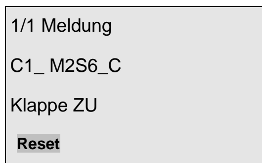
Bild 6.7.4: Anzeige einer geschlossenen BSK mit 1 Endlage
