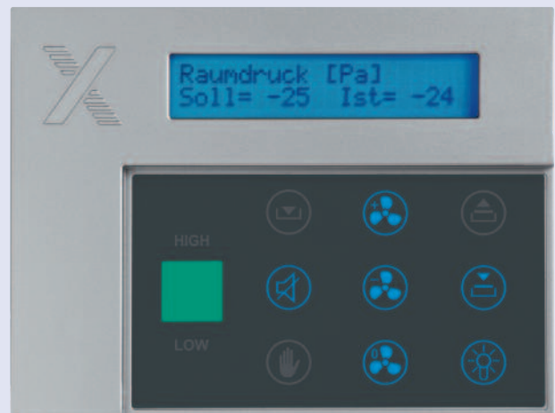
Anzeige der Soll- und Istwerte einer Druckregelung
