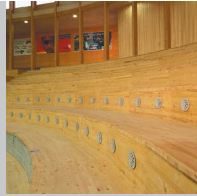
Mehrzweckhalle, Cazis GR, WAVESTEP
