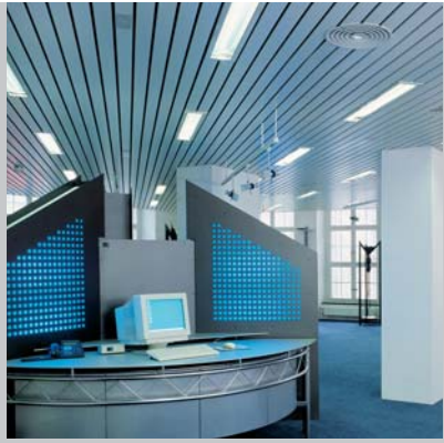
Telecom Zürich, Deckendiffuser DDR
